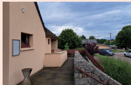
Salle culturelle rénovée énergétiquement
