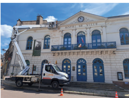
Travaux sur la toiture en mairie
